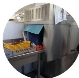
Limpieza de forma mecánica
